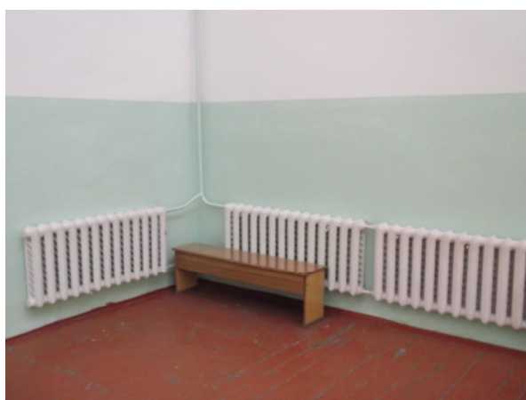
Lo scorcio di un'aula PRIMA del nostro intervento
